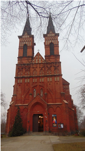
Rys. 11. Kościół pw. NMP w Rozniszewie obecnie.
